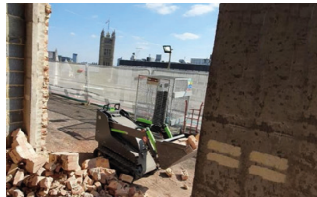
Městské stavebnictví / Demolice / Úprava terénu
